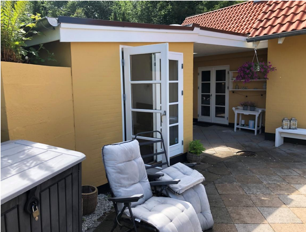
Bygn. 2 (annek) set tættere på – den gamle bygning til venstre for annekset er fjernet, kun læmuren er tilbage
